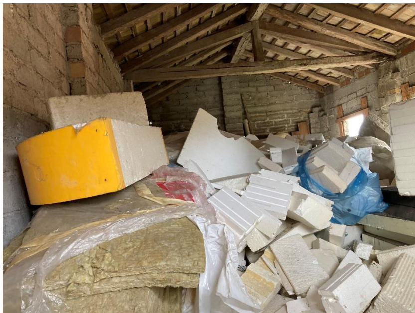
Vista interni del deposito-fienile
