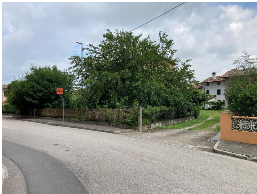
Vista esterna accesso carraio da via Villa
