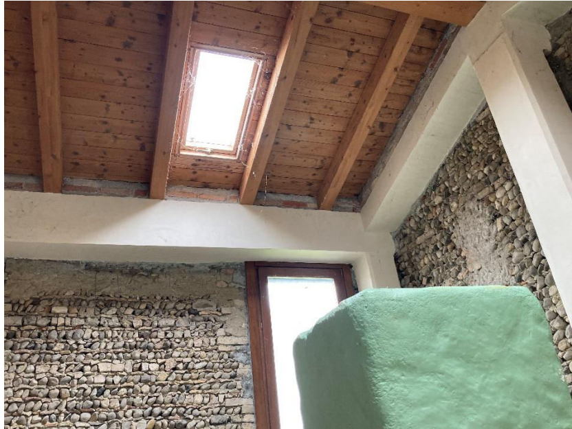
Vista interni accessorio
